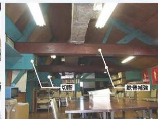
② 小屋組 鉄骨による補強の様子
