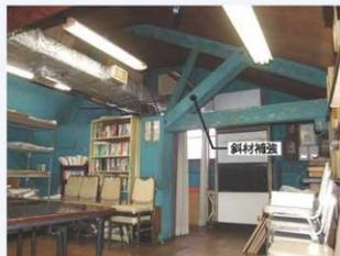
① 小屋組 斜材による補強の様子
