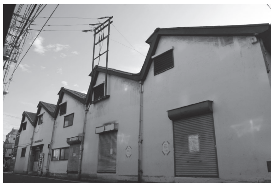
写真 1 北側に窓を持つ鋸屋根工場（2013 年）
