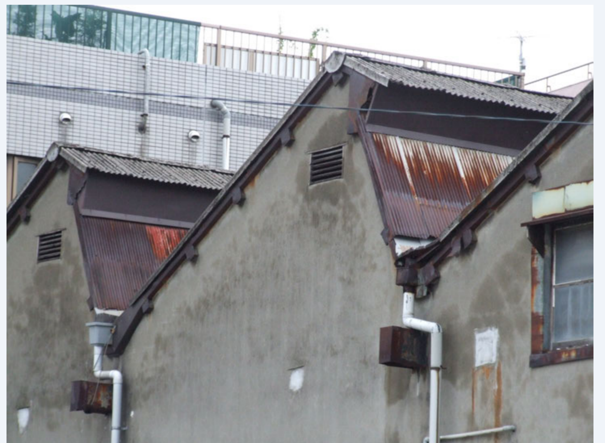
北東側から採光窓を見る
