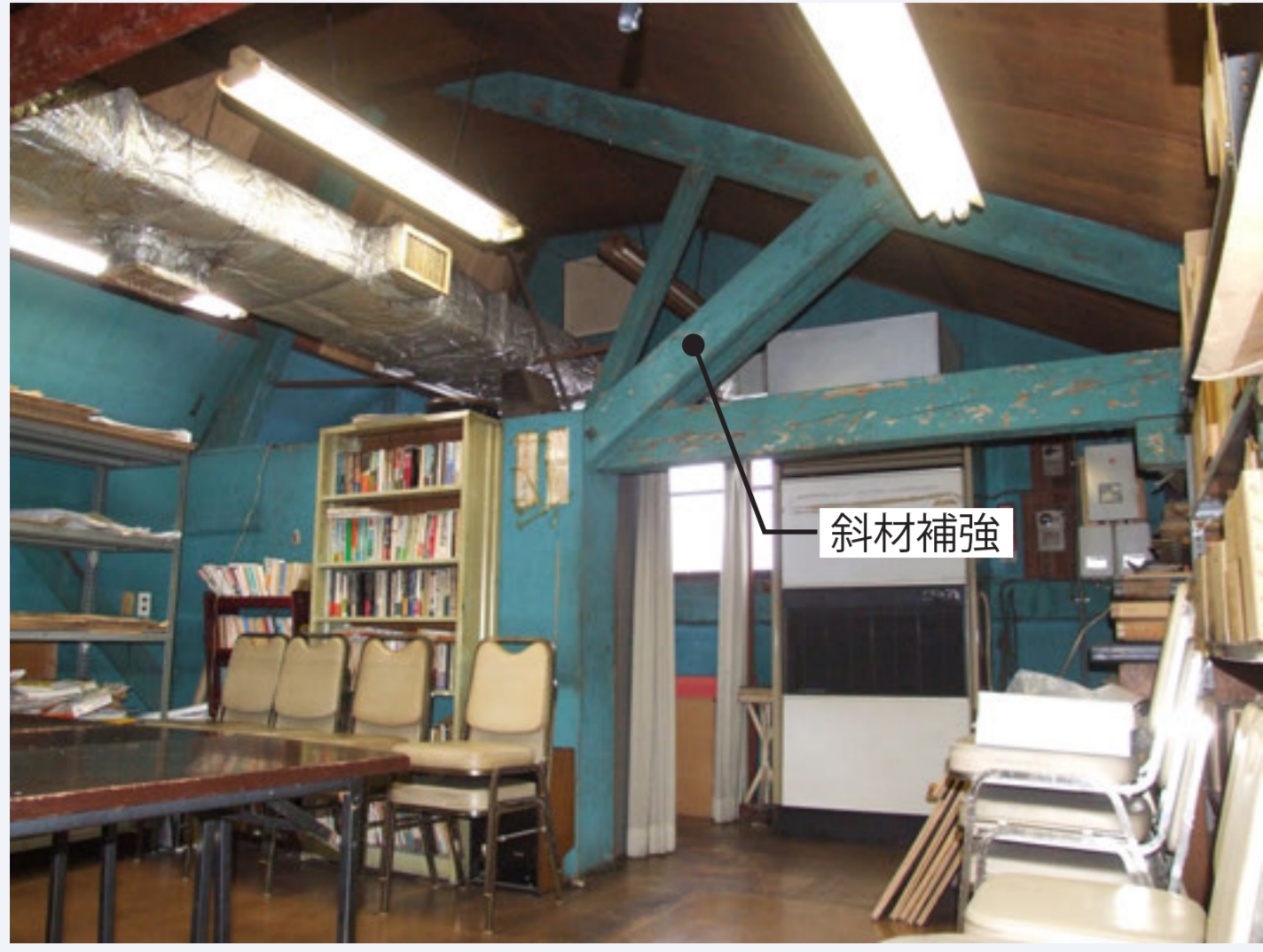
① 小屋組 斜材による補強の様子
