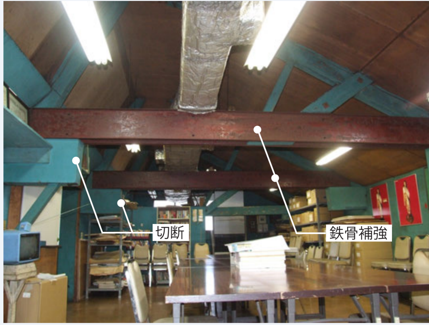
② 小屋組 鉄骨による補強の様子
